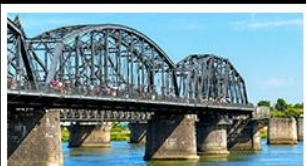
สะพานหวาดถานตง
