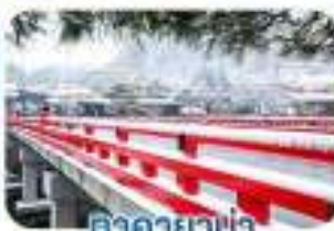
คาคายาป่า สะพานนากะบาชิ
